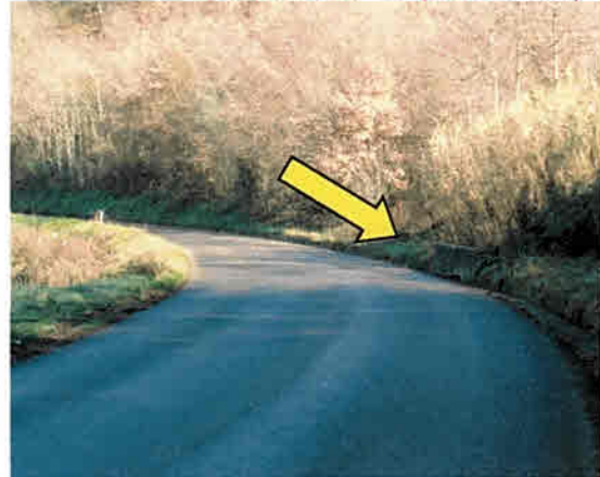
Postazione 16 bis (km 2+600)
